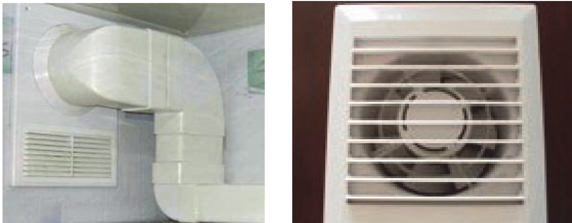
Рис. 16. Приточные системы механической вентиляции
